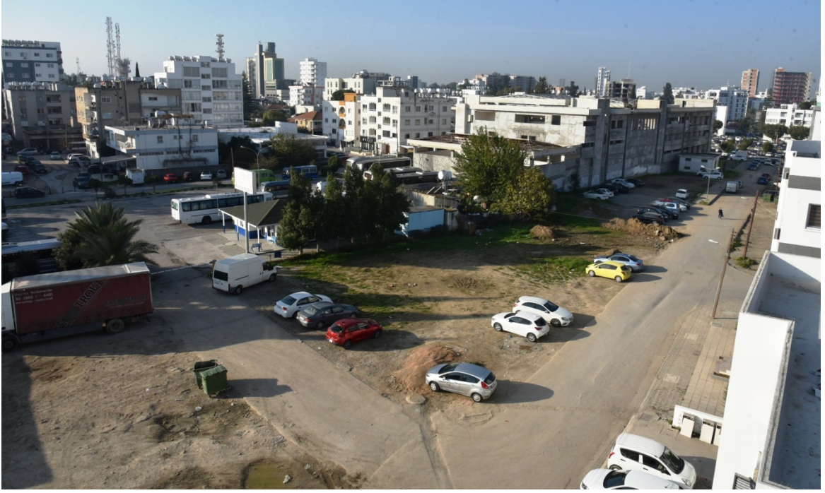
Şekil 15 Yarım kalmış Tiyatro binası ve Terminal bağlantısı
